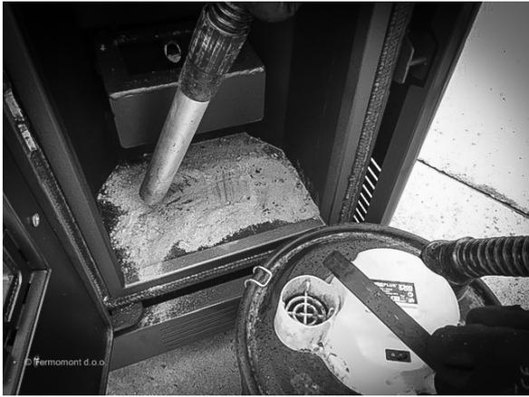
Očistiti pregradu ispod šolje gorionika, usisivačem za pepeo. Očistiti vrh cevi u kojoj se nalazi grejač za paljenje peleta. Prilikom ponovnog vraćanja šolje nazad na svoje mesto, obratiti pažnju na pravilno pozicioniranje šolje u kotlu (otvor za grejač služi kao referenca, obratiti pažnju da šolja lepo sedne na postolje, u suprotnom kotao neće raditi kako treba). Obratiti pažnju da je dihtujuća pletenica na svom mestu (po obodu šolje sa njene donje strane).
