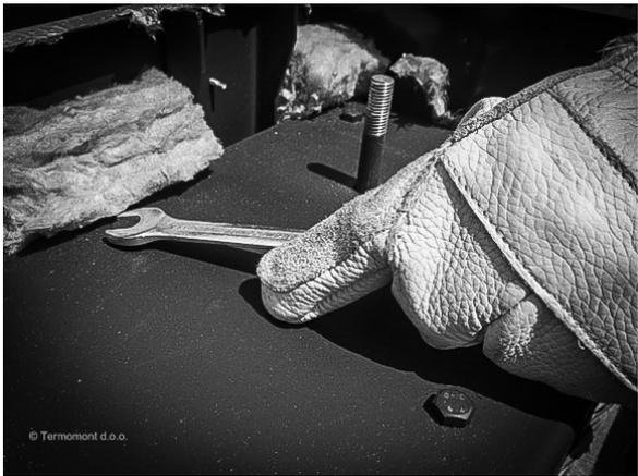
Pomoću ključa kotla ili viljuškastim ključem broj 13 potrebno je odviti sve navrtke na sledećem poklopcu od debljeg lima - koji zatvara samo ložište.
