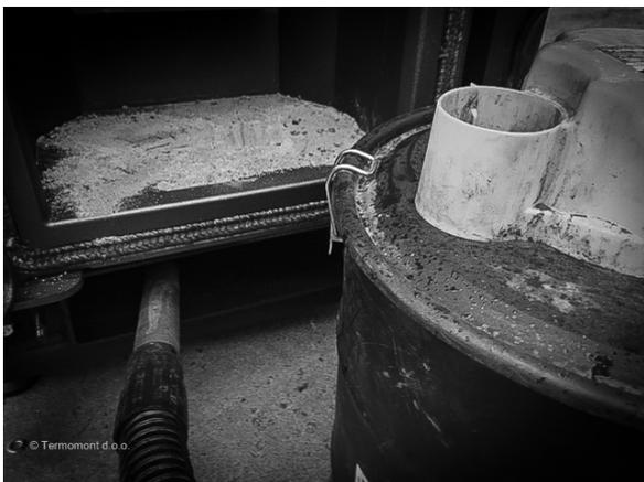
Očistiti prostor u donjem delu ložišta usisivačem za pepeo ili pomoću pribora za čišćenje (uz pomoć žarača prikazanog na slici). Prilikom vraćanja poklopca, stegnuti do kraja navrtke tako da ne ulazi falš vazduh u kotao (u suprotnom kotao neće raditi na ispravan način).
