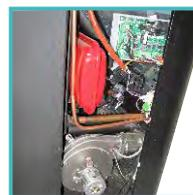
Ekspanzijska posuda, ventilator za odvod dima
